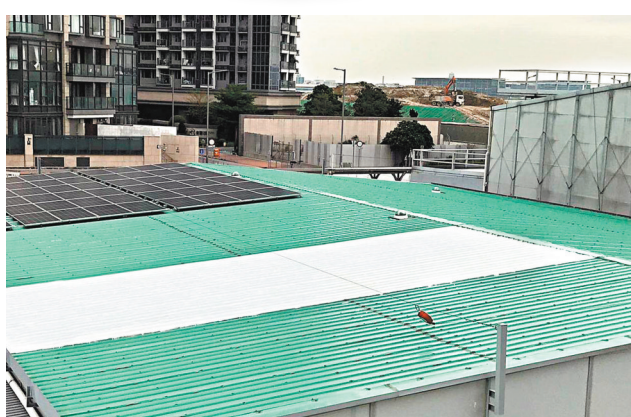
● 左圖顯示天台中間部分塗了團隊的白色塗料，右圖可見有塗料的位置 (見深藍色部分) 所測得的表面溫度，比沒有塗料的位置 (見紅色部分) 降溫多達30度左右。受訪者供圖
