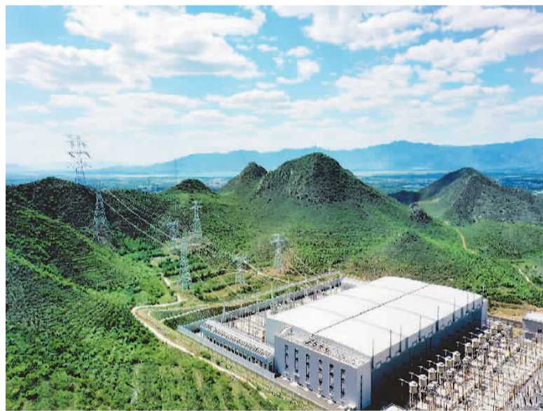
国家电网张北柔直工程延庆换流站将绿电送往北京。
