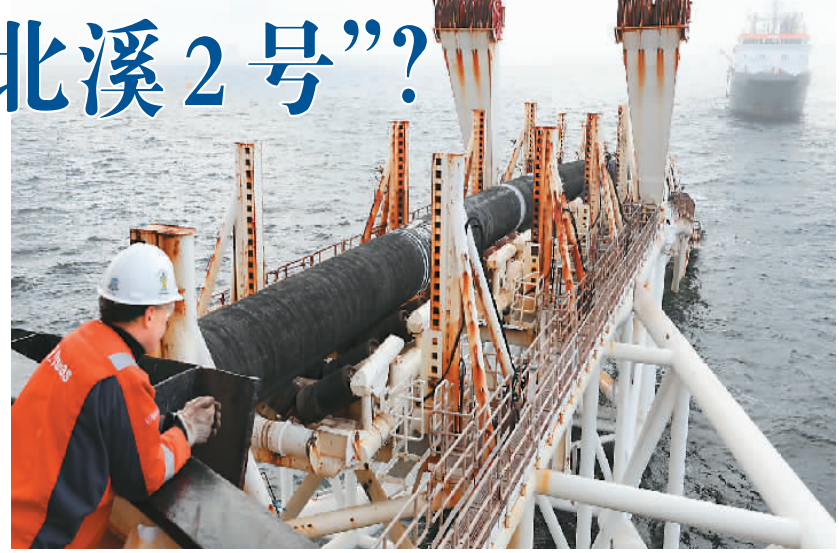
图为2018年11月,在德国拉格附近的海域,一名工人在“北溪2号”天然气管道项目铺管船上工作。新华社/法新
