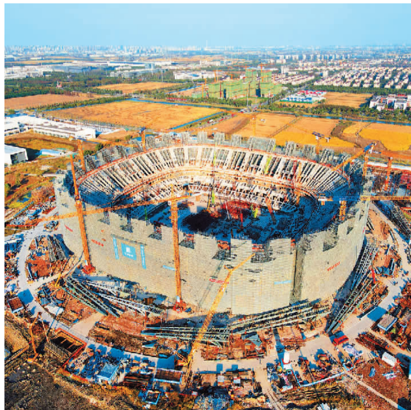
近日,江苏省昆山市专业足球场项目主体结构完工,该足球场是一座满足国际足联比赛要求的国际一流专业足球场,由中建八局三公司苏南分公司承建。图为足球场施工现场。 王锐 杨志国摄影报道
