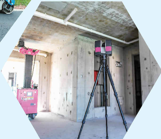
▼11月9日，广东佛山顺德的在建住宅项目凤桐花园，测量机器人（右）和混凝土天花板打磨机器人（左）正在工作。 新华社记者 毛思倩摄
