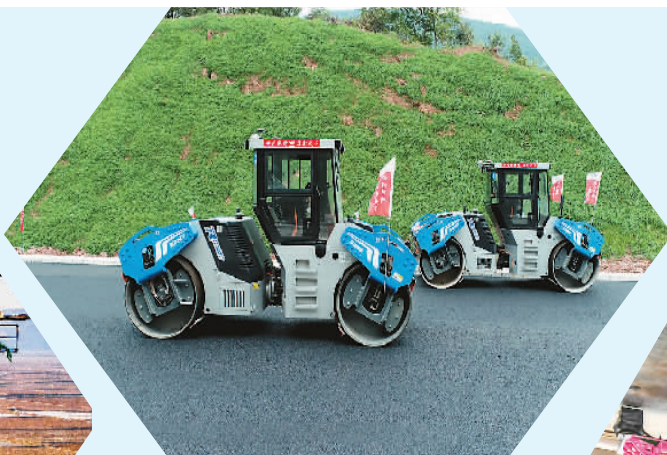
▲6月23日，四川省巴中市通江县境内的镇广高速王坪至通江段，无人自动化摊铺设备在施工作业。 程 聪摄（人民视觉）
