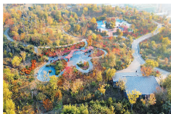
江苏省徐州市五山公园原为山体、采石场废弃地。当地政府利用“海绵城市”理念实施山体生态修复再造，将“城市伤疤”打造成运动休闲公园。图为日前无人机拍摄的公园。 孙升贤摄（人民视觉）
