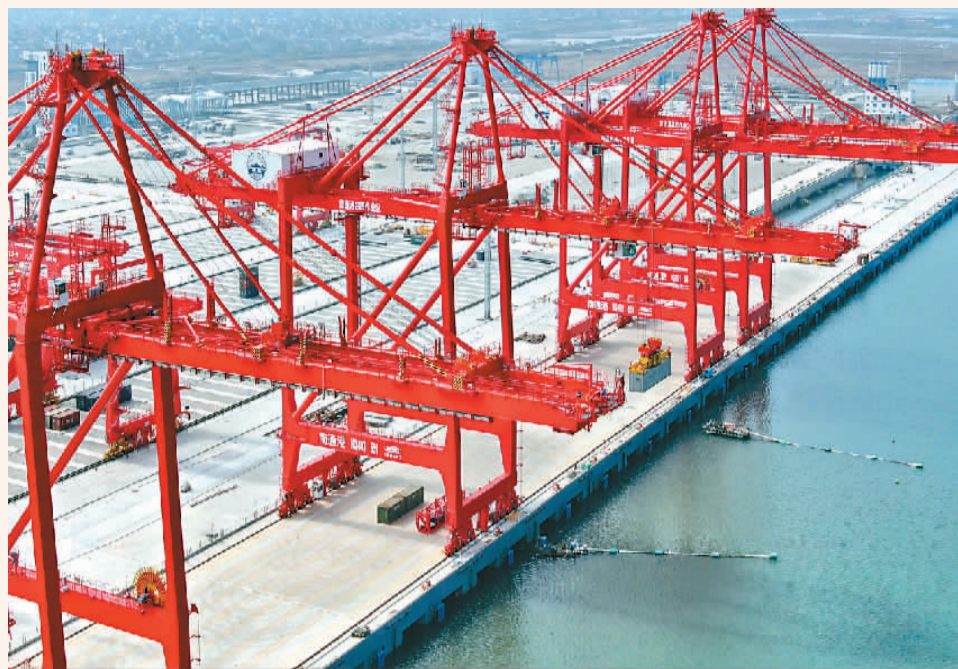
江苏省启东市通州湾位于“一带一路”倡议与长江经济带、长三角一体化发展等国家战略叠加交汇点，该湾新出海口吕四起步港区（L4）码头工程新貌。图为十一月十六日拍摄的吕四起步港区（L4）码头工程新貌。 许丛军摄（人民视觉）
