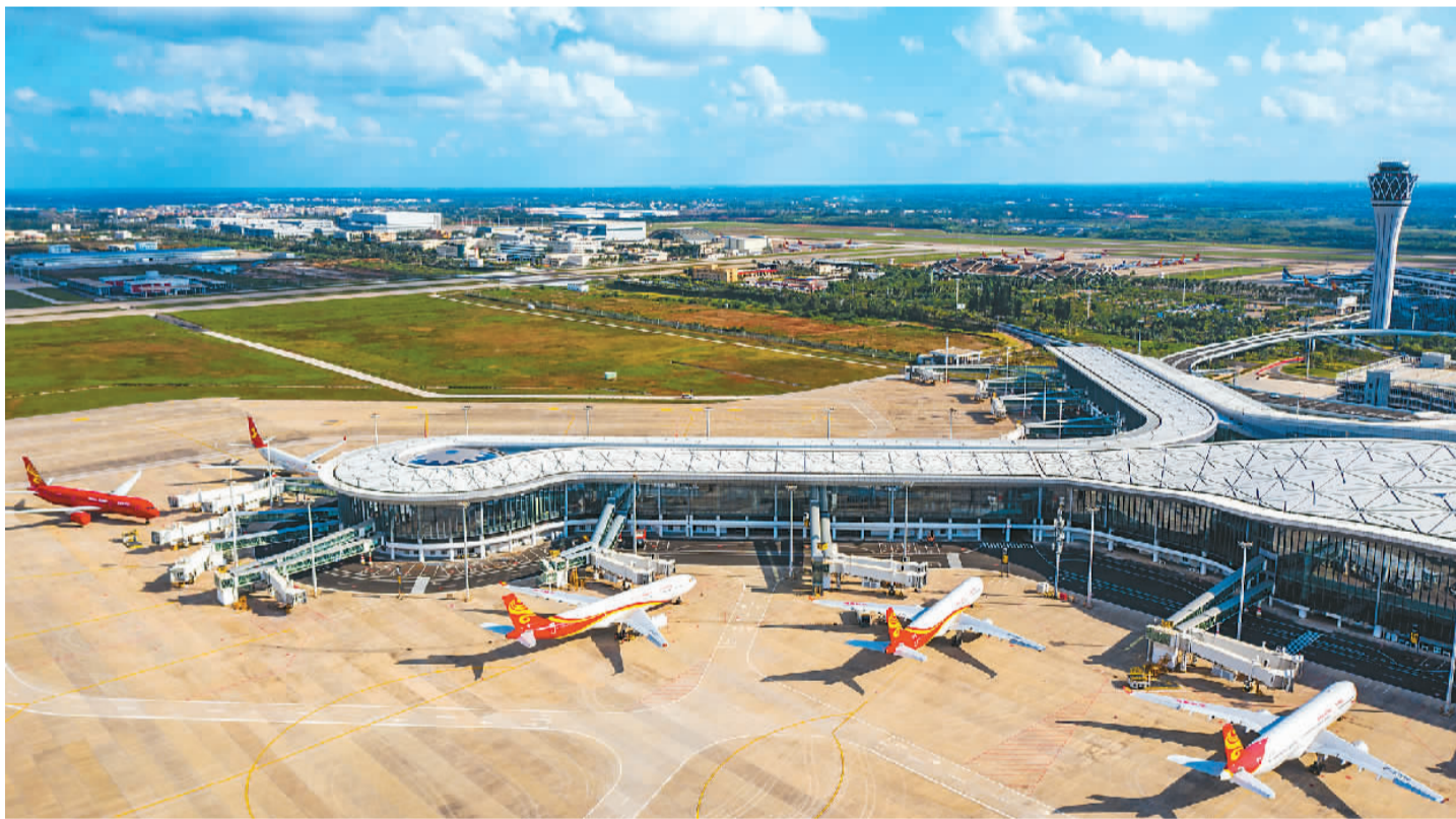
海口美兰国际机场二期扩建项目计划于12月2日投入运营。该项目是海南省重点工程,是加强与“一带一路”沿线国家互联互通的重要一环。图为海口美兰国际机场二期航站楼。石中华摄(人民视觉)
