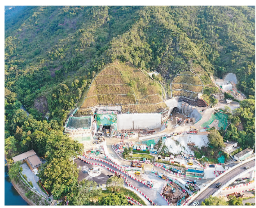
▲ 岩洞工程俯瞰。（中国建筑国际供图）
