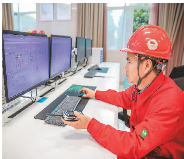
日前,中国石油西南油气田公司相国寺储气库加入全国储气库调峰保供行列,为守护万家温暖再增“底气”。图为工作人员巡查设备运行情况。新华社记者黄伟摄
