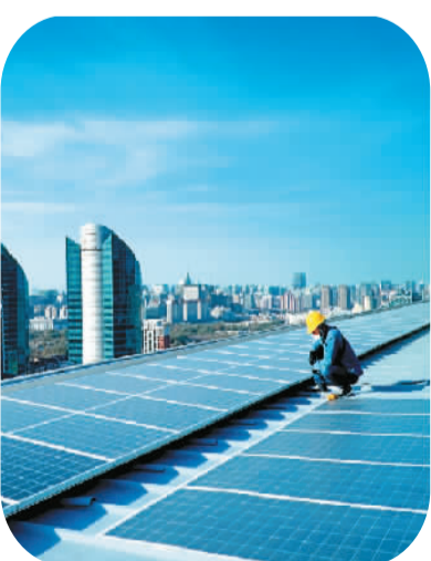
为高标准兑现北京2022年冬奥会和冬残奥会可持续性承诺、推动城市绿色发展,北京市积极实施六项阳光工程。图为工人在北京的国际大厦楼顶对分布式光伏项目进行最后调试。本报记者 贺勇摄
