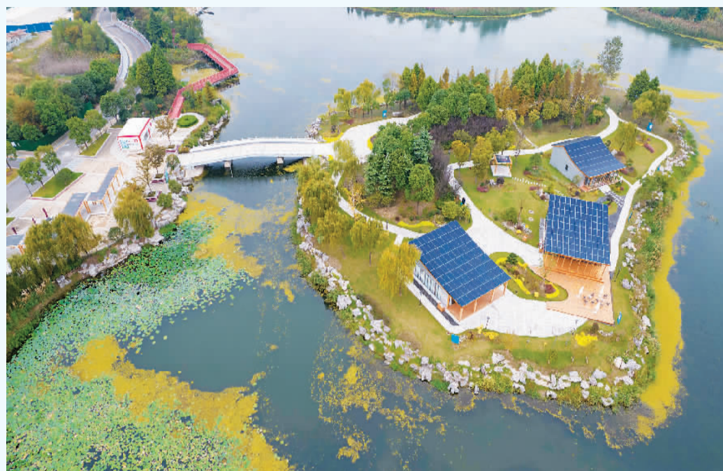
“太阳里”城市客厅位于江苏（泰州）新能源产业园内，是国内零能耗低碳建筑示范项目。该项目预计能实现年减排二氧化碳120吨。图为“太阳里”城市客厅一角。汤德宏摄（人民视觉）
