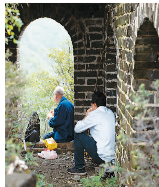
9月28日，抢险工程技术指导程永茂（左）、项目经理张凤明在还未进行修缮的171号敌楼内吃干粮。65岁的程永茂是一名土生土长的怀柔人，从2004年起开始参与当地长城保护相关工程。至今坚守在第一线。为了指导施工，他每周至少爬一次长城，多则爬三四次。截至目前，程永茂已带领团队完成怀柔区内总长近2万米的长城抢险加固任务。他说，希望能够通过修缮延长长城寿命，“给后人留点真东西”。
