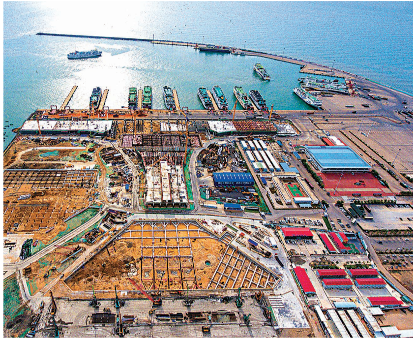
遲福林建議，中國制定實施以CPTPP服務貿易開放水平基本相近的跨境服務貿易負面清單。圖為海南自由貿易港的海口新海港客運綜合樞紐項目在施工。資料圖片
