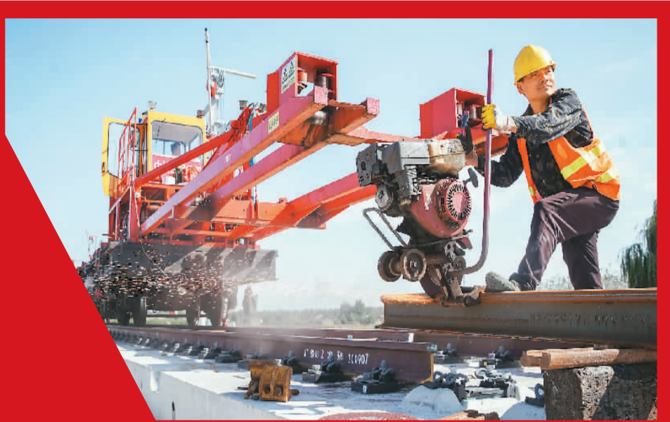
▲京唐城际铁路建设工程是京津冀协同发展重点项目，预计2022年建成通车。图为施工人员在现场切割钢轨。 邢子鸣摄（人民视觉）
