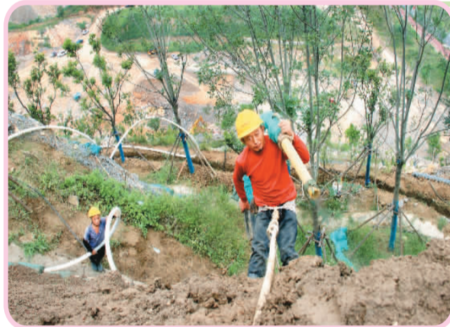
在安徽省淮北市泉山废弃矿口生态修复项目治理区，工作人员在进行坡面高次团粒喷播绿化作业。周方玲摄（人民图片）
