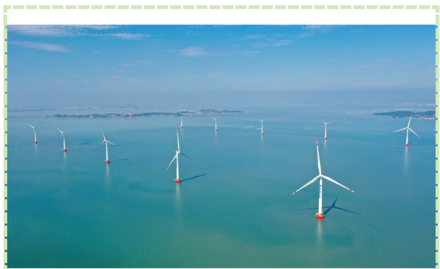
海坛海峡海上风电项目风机吊装完毕。(中国华电供图)
