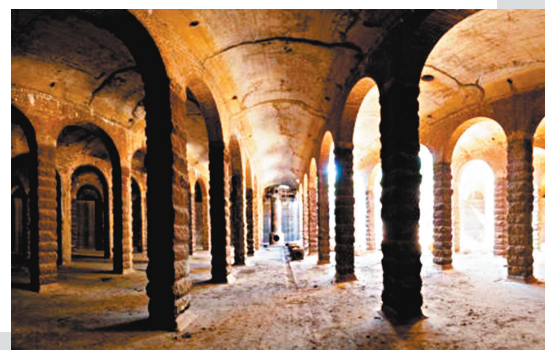
● 主教山配水庫上蓋在很早之前已被當成一個公共空間。
