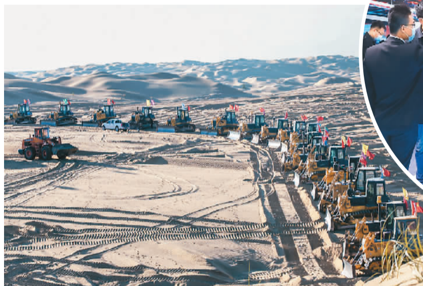
▲10月16日，在内蒙古西基地库布其200万千瓦光伏治沙项目区待命的施工机械。 (受访者供图)
