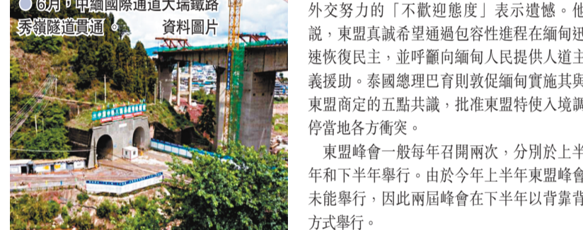
6月，中緬國際通道大瑞鐵路秀嶺隧道貫通。資料圖片
