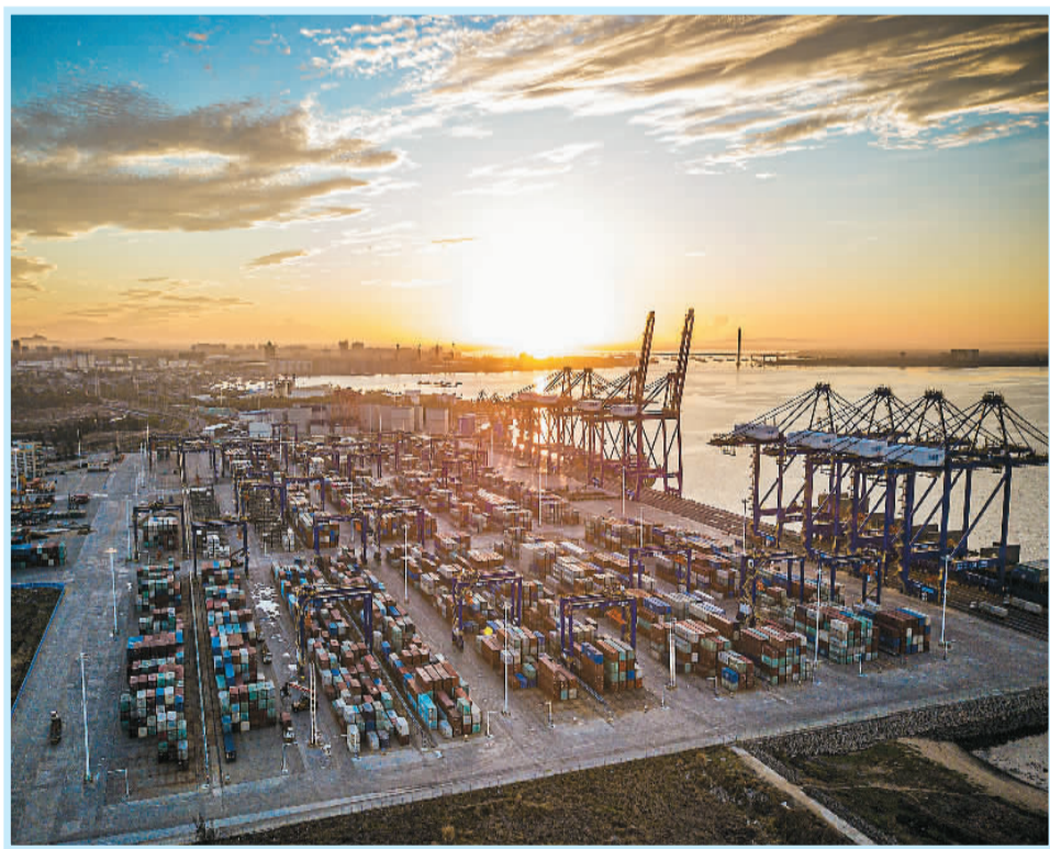
在海南洋浦经济开发区拍摄的洋浦国际集装箱码头（无人机照片）。
