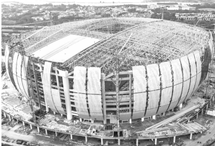
雅加达国际体育馆年底可投运 由Jakarta Propertindo公司建造的雅加达国际体育馆,其施工进度已达78%,并预定今年年底建成并开始投运。
