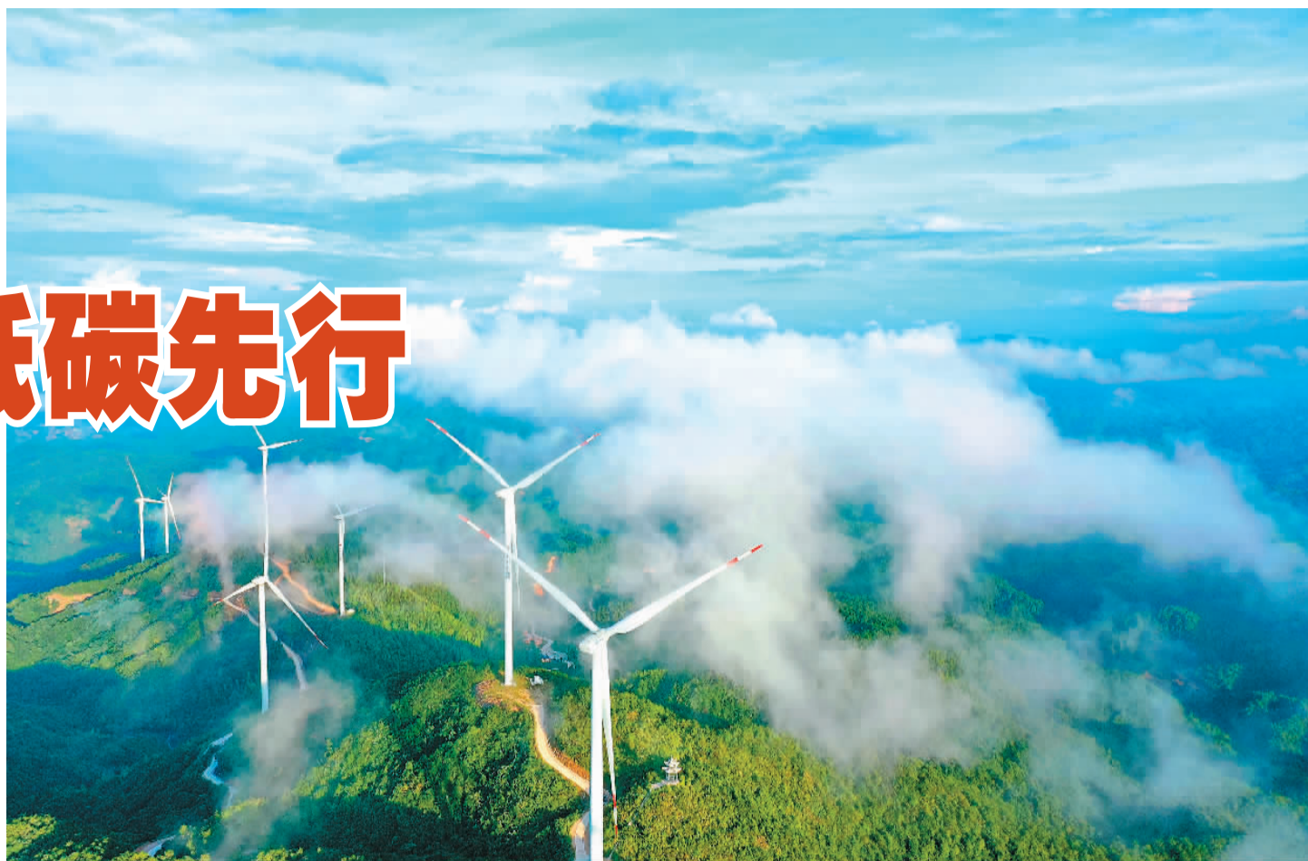
江西省赣州市会昌县清溪乡盘古峰风力发电场，一台台风力发电机矗立在连绵的青山间。盘古峰风力发电场共有26台2000千瓦风力发电机组，每年可节约标煤38万吨，有效促进节能减排。 朱海鹏摄（人民日报）
