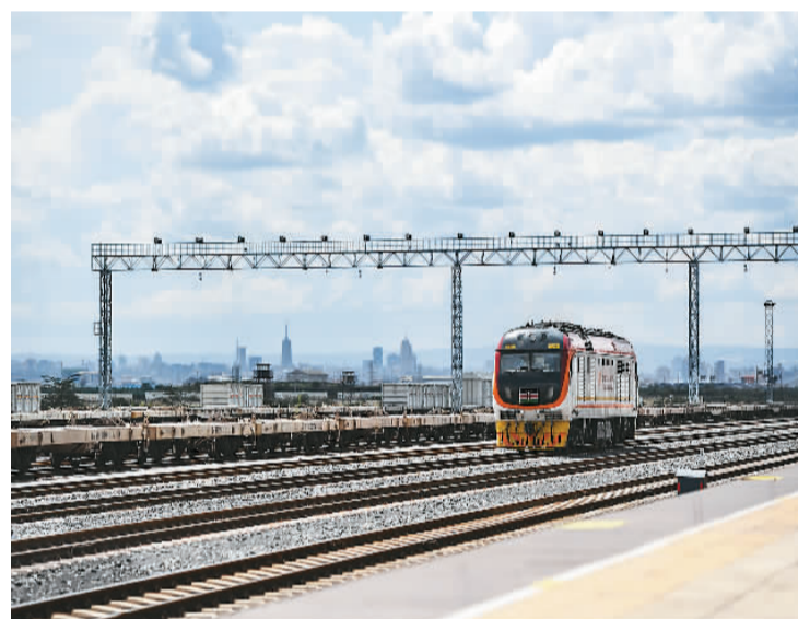
▲中国建交承建运营的蒙内铁路是肯尼亚在近100年间建设的第一条铁路。该铁路在建设过程中为当地创造了数以万计的就业岗位。图为机车在蒙内铁路铁轨上运行。
