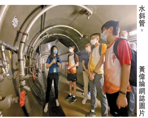
「寶珊排水隧道」上方鋪設了排水斜管。 黃偉倫網誌圖片
