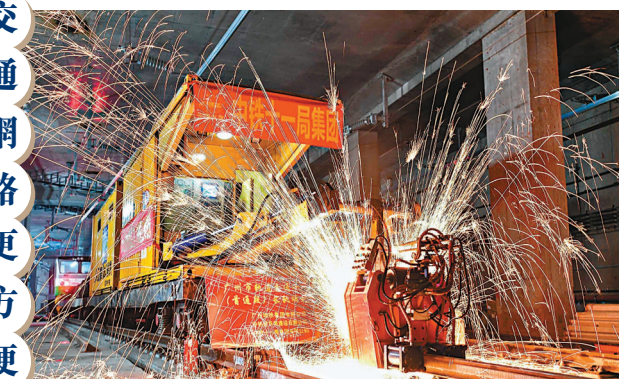
●廣州地鐵18號線開通。圖為焊接該線鋼軌接頭。 新華社
