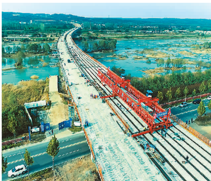
10月18日,中铁上海工程局承建的新伊高速(河南新安县至洛阳市伊川县)全线控制性工程——洛河特大桥顺利实现贯通。该高速明年建成通车后,洛阳西南方向将再添一条交通大动脉。 王纲 胡育松摄
