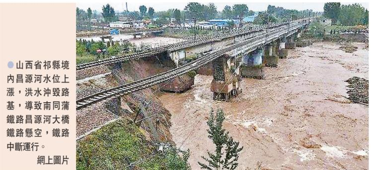
●山西省祁縣境內昌源河水位上漲，洪水沖毀路基，導致南同蒲鐵路昌源河大橋鐵路懸空，鐵路中斷運行。網上圖片
