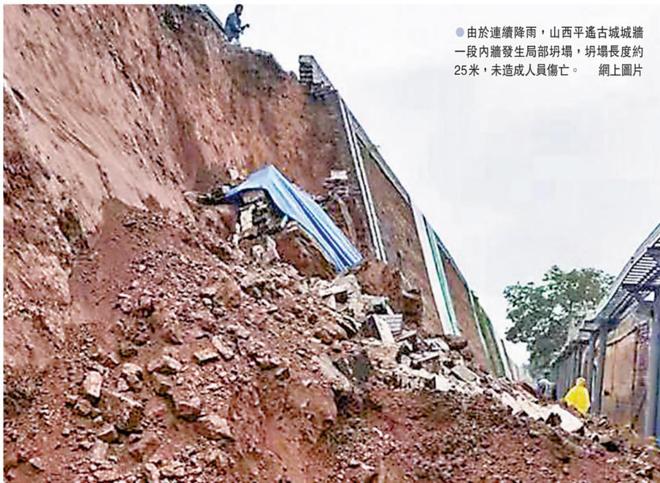
●由於連續降雨，山西平遙古城城牆一段內牆發生局部坍塌，坍塌長度約25米，未造成人員傷亡。網上圖片
