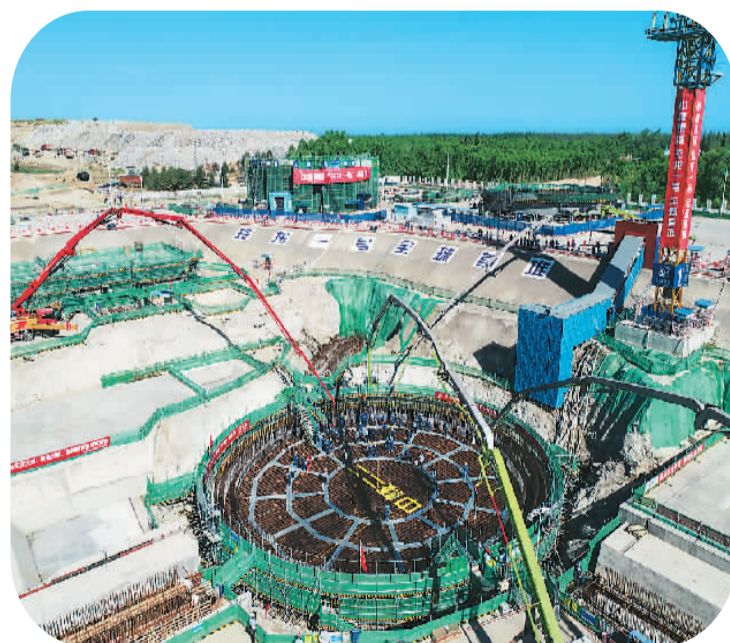
海南昌江“玲龙一号”施工现场。
