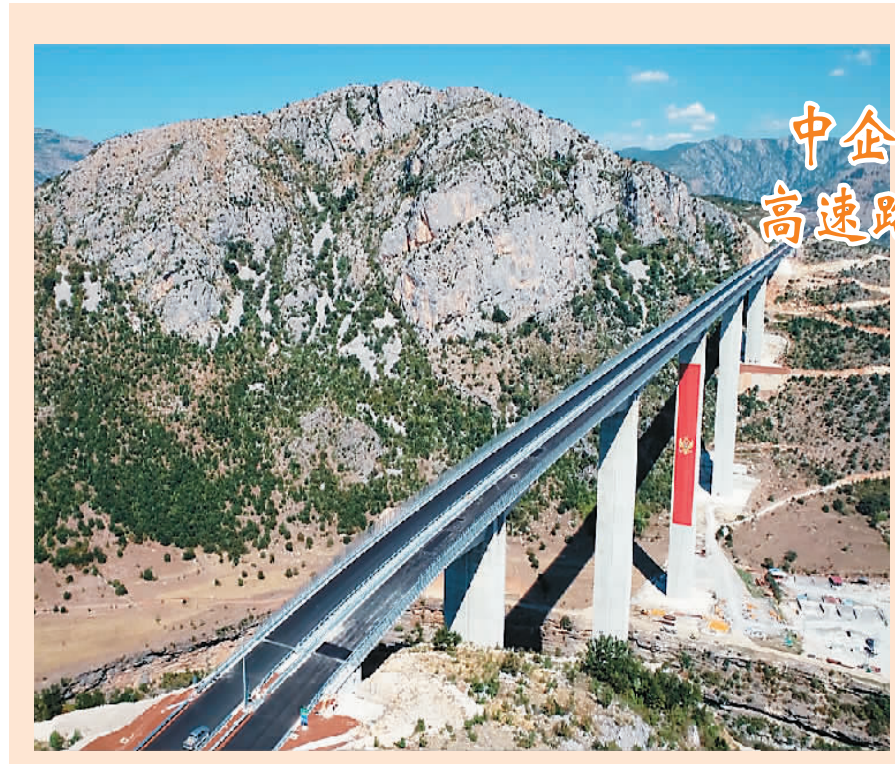
黑山南北高速公路项目关键控制性工程莫拉查特大桥。
