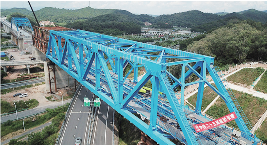
南沙港鐵路施工現場，長112米、重1785噸的鋼桁梁順利頂推到位。畢傑杰 黃詩偉攝
