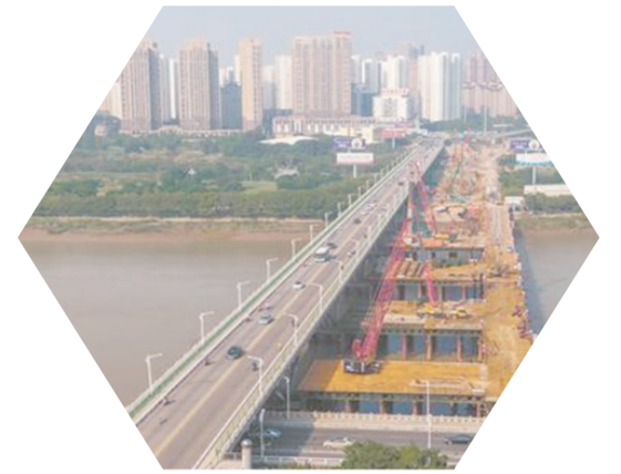
主體全長270米的鋼棧橋已搭建完成（陳起拓攝）
