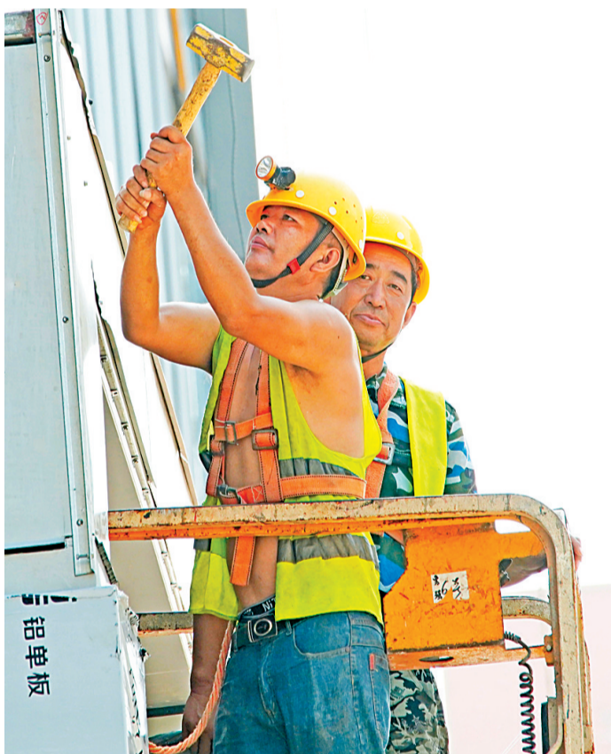
↑ 頭頂烈日高空作業。
