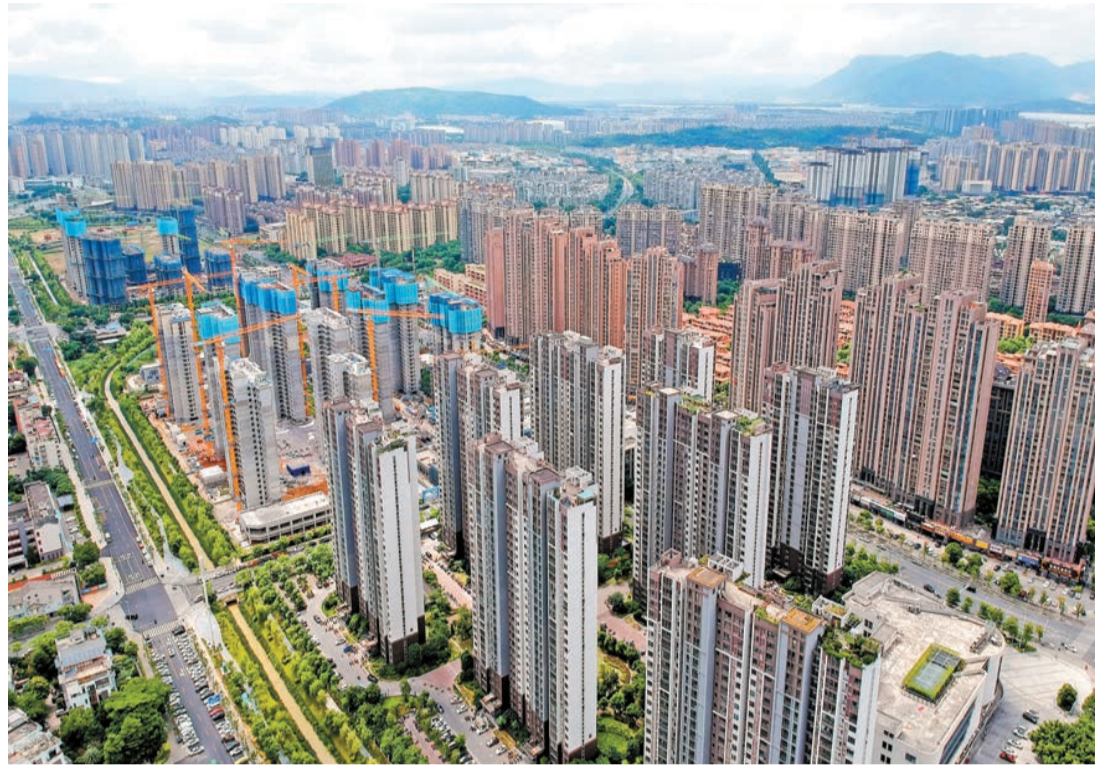
福建福州一處新建住宅。 中新社
