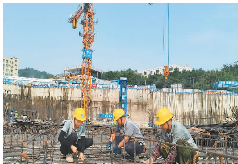
中秋节到来之际，广东省深圳市南山区羊台书苑项目施工现场的工人们依旧坚守岗位，全力保障项目建设快速推进。羊台书苑项目建筑面积约30.55万平方米，为产业、教育、居住一体化社区，建成后将优化人居环境和社区教育资源配置，进一步加速深圳科教强市建设与城市面貌更新。图为9月18日，中建二二公司的工人们在现场作业。 王祖华摄（人民视觉）
