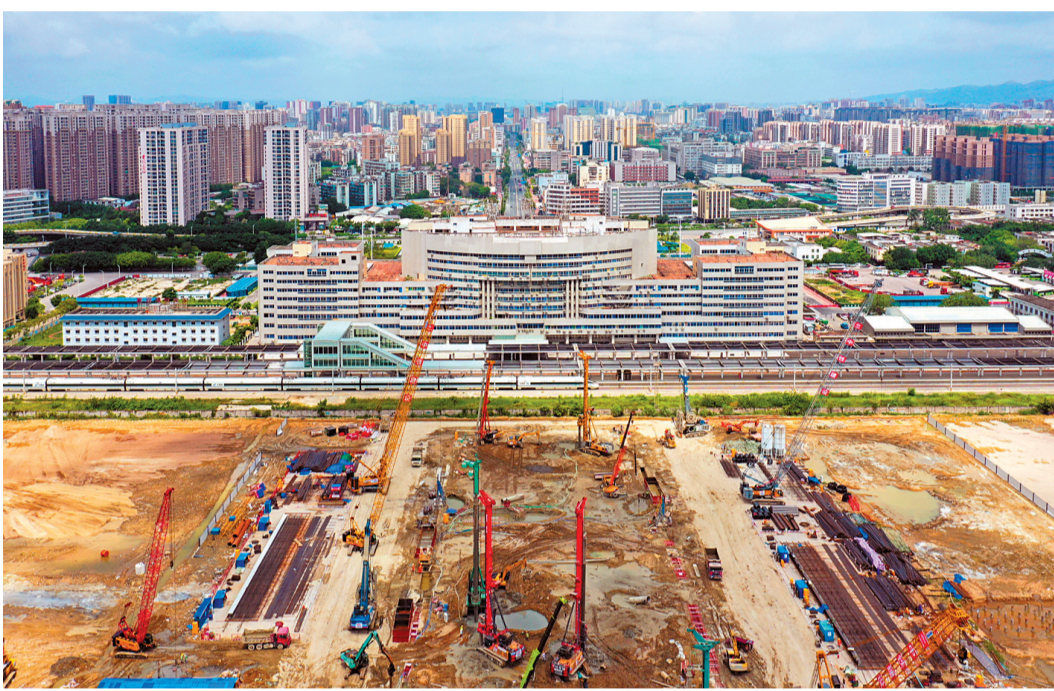
↑汕頭站及站區工程全面鋪開。
