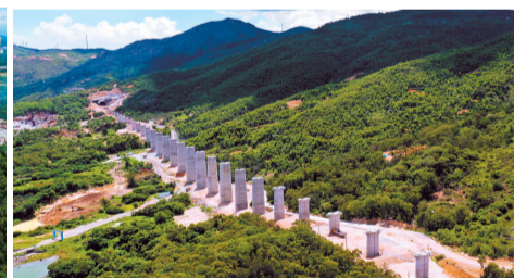
↑揭陽惠來仙庵隧道出口裏行特大橋成排的高聳橋墩點綴在綠水青山之中。
