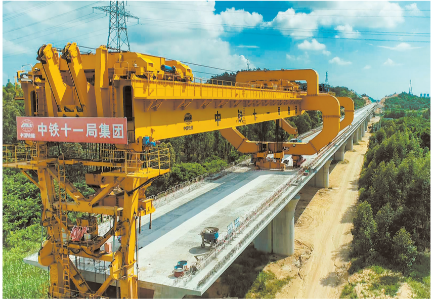
汕汕鐵路潮陽段架梁架梁架梁節節推進。
