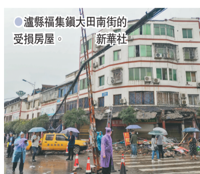
● 瀘縣福集鎮大田南街的新華社受損房屋。
