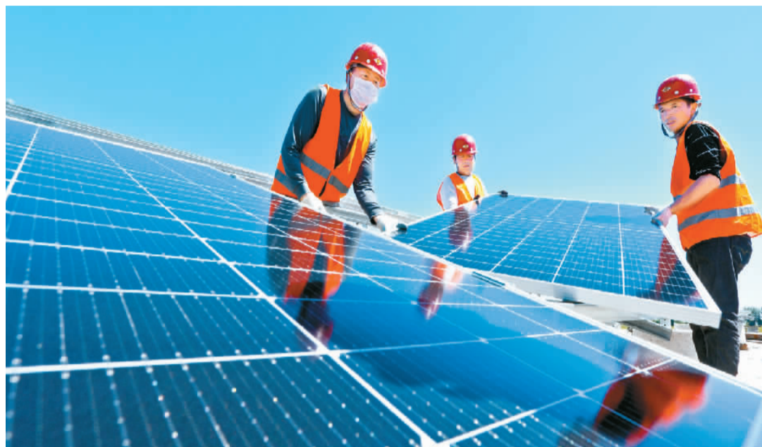
甘肃省张掖市高台县100兆瓦分布式光伏发电项目近日开工建设。高台县8个镇74个村的农户和所在地公共服务单位屋顶上安装分布式光伏发电板,闲置屋顶变身“绿电”生产线。图为项目工作人员正在安装光伏发电板。王将摄(人民视觉)
