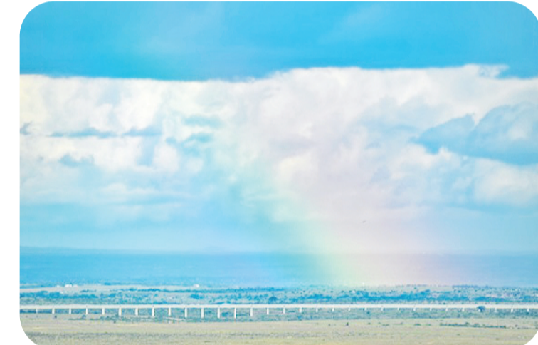
2020年4月29日在肯尼亚内罗毕拍摄的彩虹下的蒙内铁路。新华社发(李琰摄)
