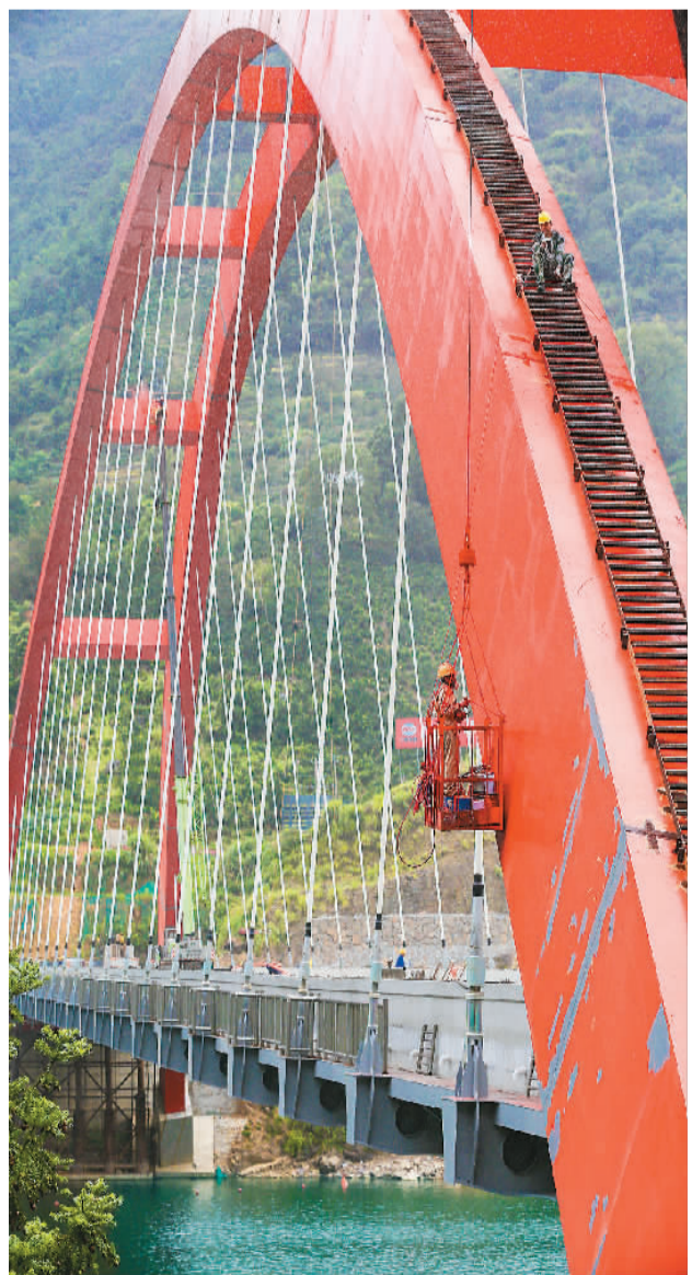
作为安徽省歙县新安江沿线两岸群众“渡改桥”重点工程和巩固脱贫攻坚成果的关键性民生工程，新安江跨江大桥各项施工正在全力冲刺，以保障10月1日前通车。图为9月12日，工人进行拱圈喷漆施工。 郑宏摄（人民视觉）
