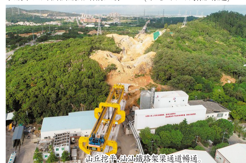
山丘挖平，汕汕鐵路架梁通道暢通。
