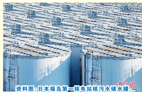
资料图:日本福岛第一核电站核污水储水罐。
