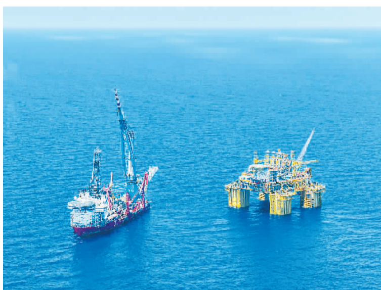
在海南陵水海域拍摄的“深海一号”大气田。 新华社记者 蒲晓旭摄
