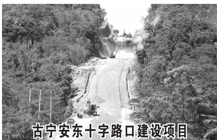
古宁安东十字路口建设项目 公共工程与民居部定下指标,西瓜哇省古宁安(Kuningan)东十字路口建设项目必须在今年11月竣工,上述工程完成之后,希望能缓解并里汶(Cirebon)-古宁安路线的交通堵塞现象。
