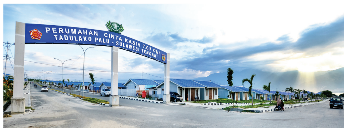
慈济巴路大爱一、二村设有学校、综合大楼、等设施，这项援助是由慈济印尼分会、黄奕聪慈善基金会(Eka Tjipta Foundation)、印多福食品公司(Indofood)等各方合作完成兴建。
