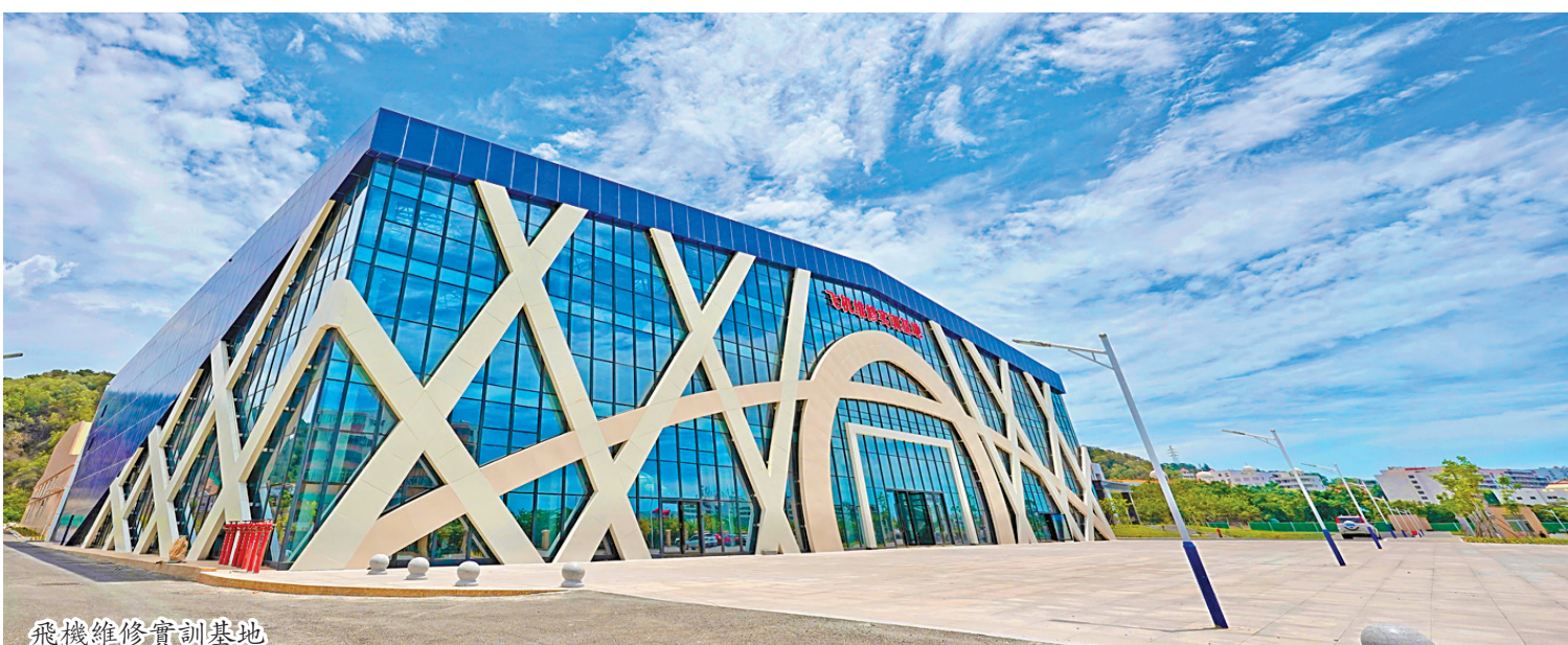
飛機維修實訓基地
