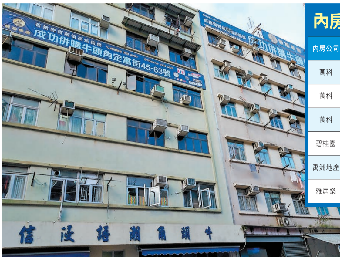
定富街45至63號(單號)物業鄰近港鐵牛頭角站，具重建價值。 資料圖片
