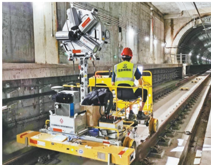
智能檢測裝備正在作業。
