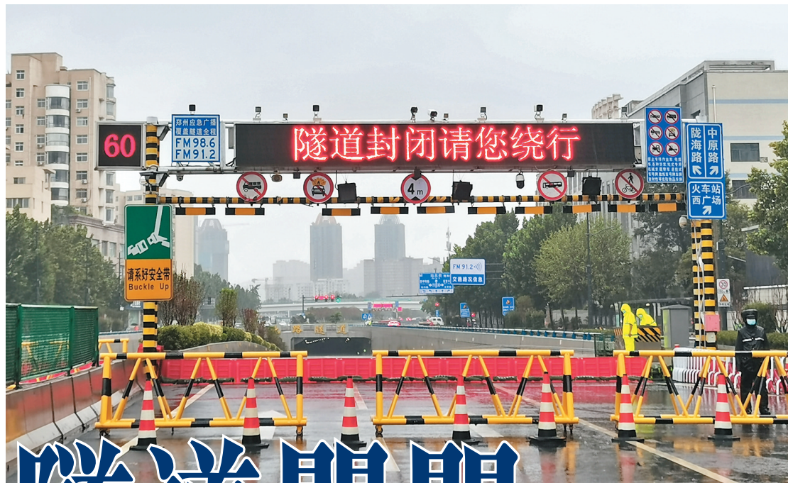
●22日，鄭州城區67座橋涵隧道、23座小型鐵路橋涵，啟動封堵禁行措施。圖為京廣北路隧道入口封閉。中新社
