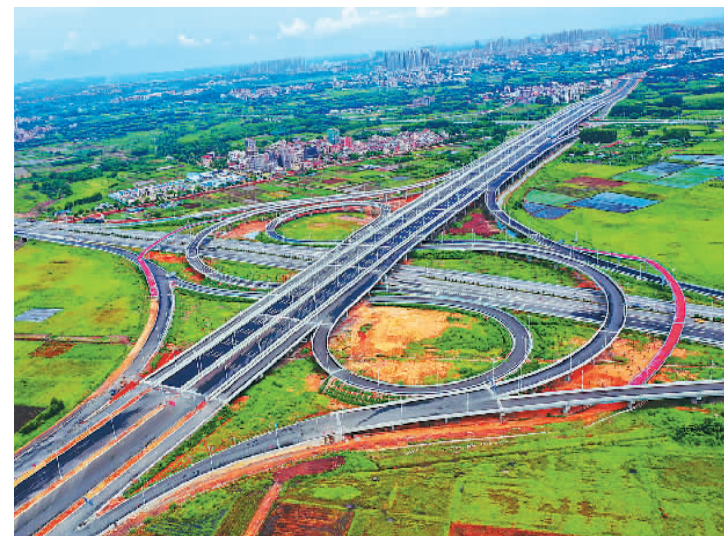
日前,位于广东省湛江市的湛江大道项目桥梁工程已完成95%,湛江大道全长约22公里,项目建成后将为湛江打造广东新的增长极和全国性综合交通枢纽提供有力支撑。图为中建路桥集团承建的湛江大道湖光快线互通立交特大桥。 姚胜金摄
